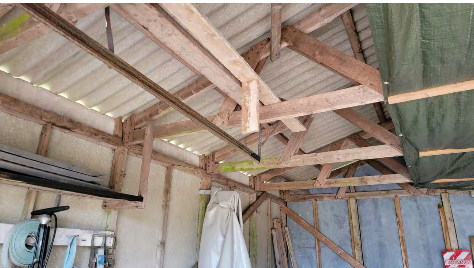
Figur 5. Tagkonstruktionen af carporten og skuret på Stadionvej 65.
