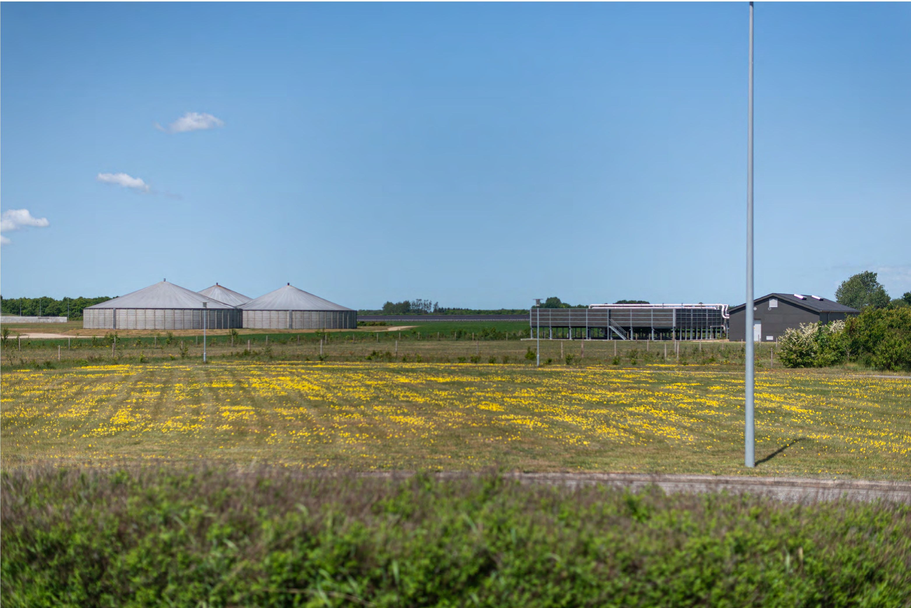
2. Rundkørsel ved Herningvej - Åhusevej
