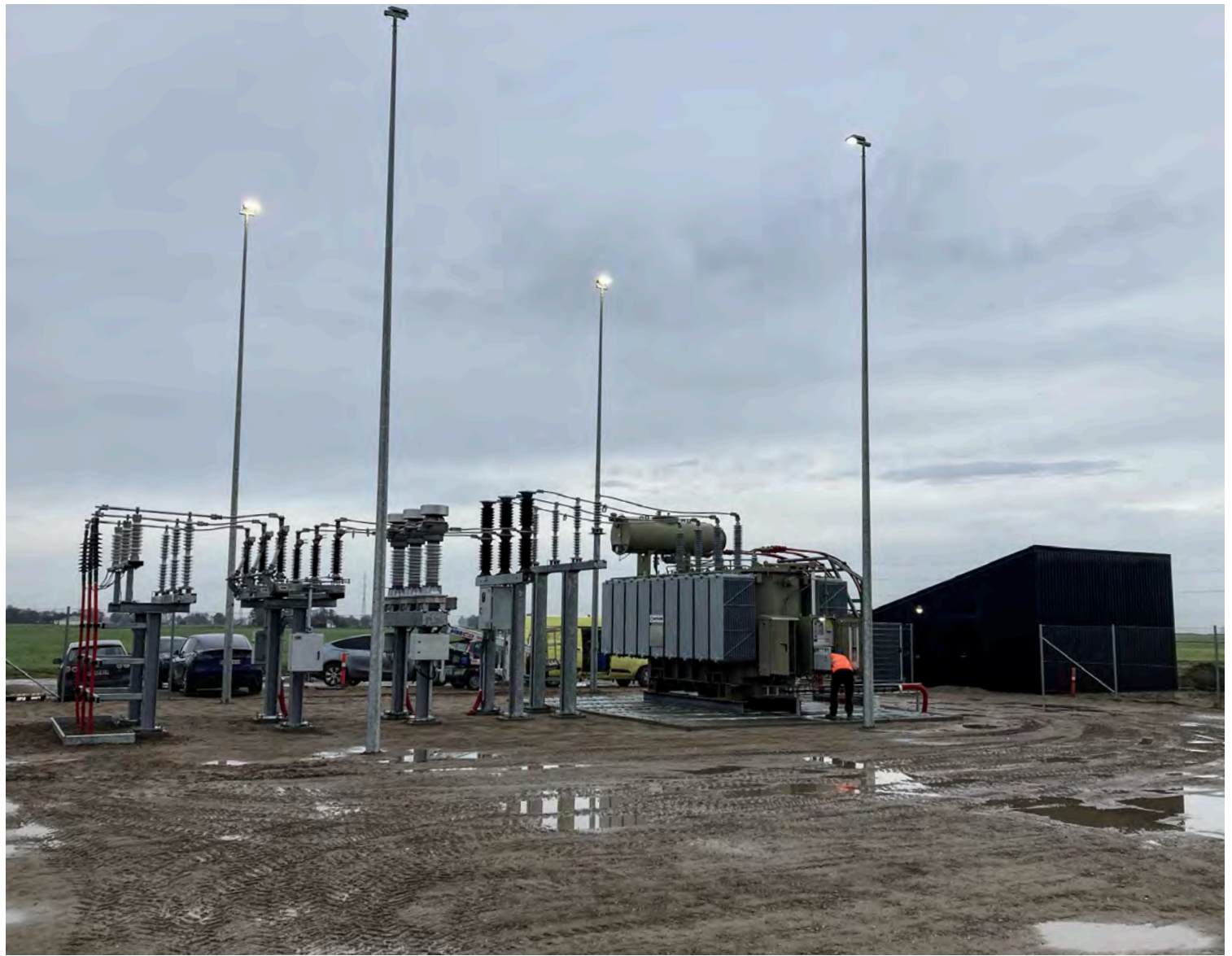
60/33kV stationen fra Nr. Øksesø det er en 50MVA transformer – Eurowind projekt
