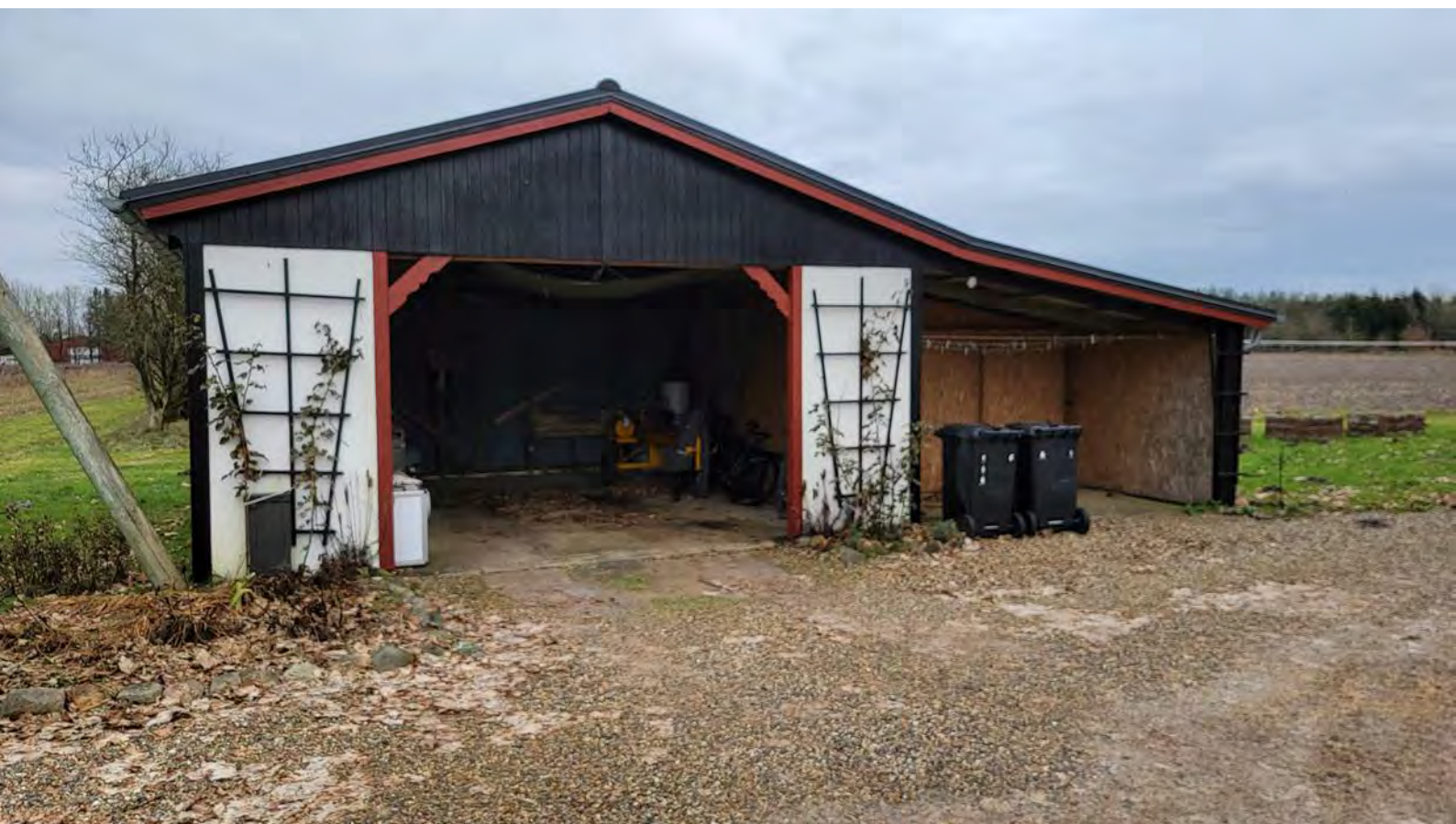
Figur 4. Tilhørende carport og skur på Stadionvej 65.
