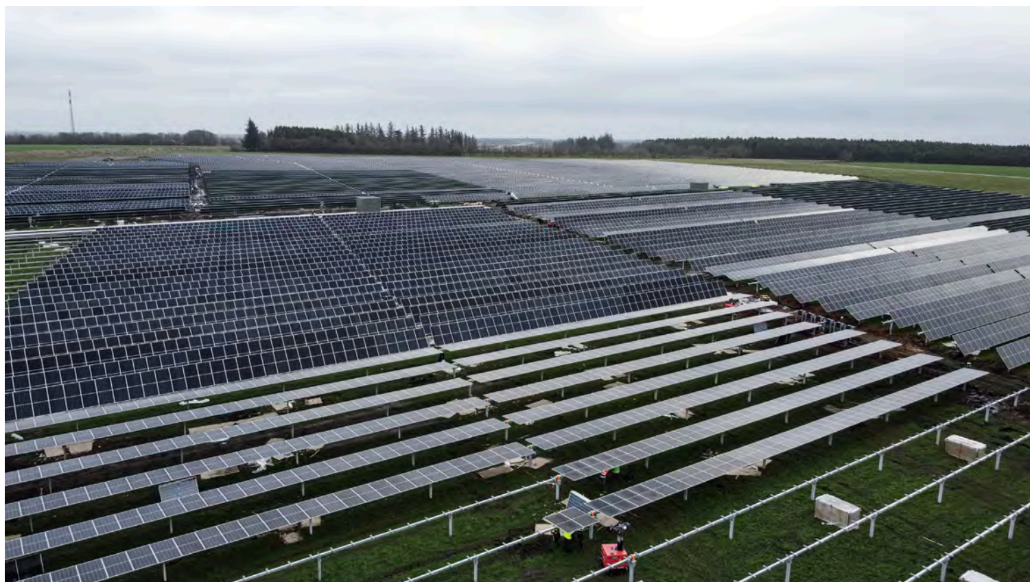
Afstand mellem rækker af paneler – kilde: Eurowind Energy
