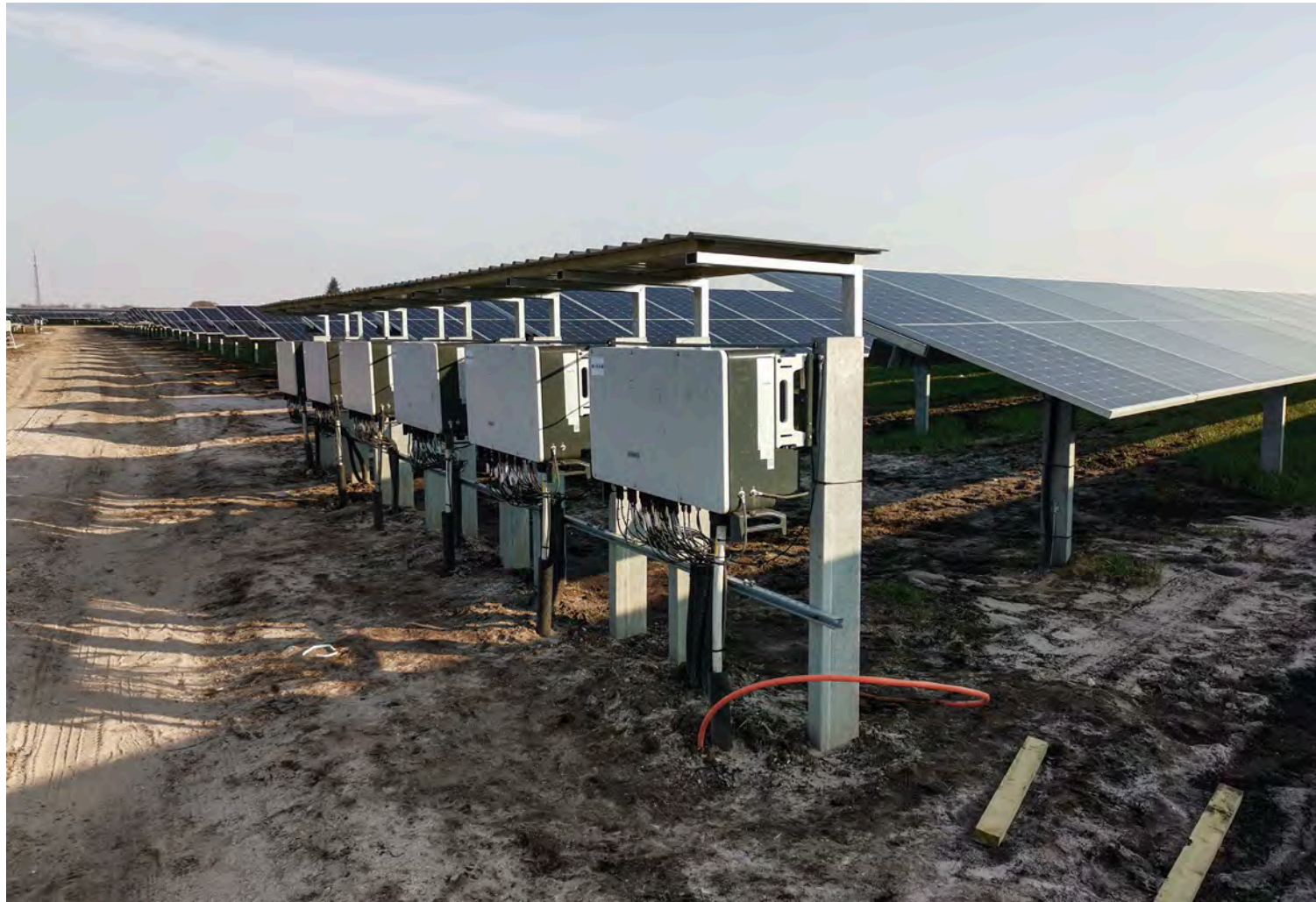
String invertere (uden Trafobus) – kilde: Eurowind Energy
